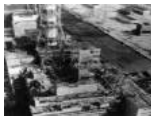
Іл. 32.14. Аварія на Чорнобильській АЕС
