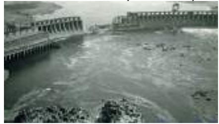
Іл. 32.7. Зруйнована вибухом гребля Дніпрогесу в 1941 р.
