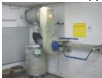
Іл. 28.5. Фільтровентиляційний агрегат
