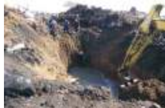
Іл. 33.11. Викопування водовідвідної каналу
